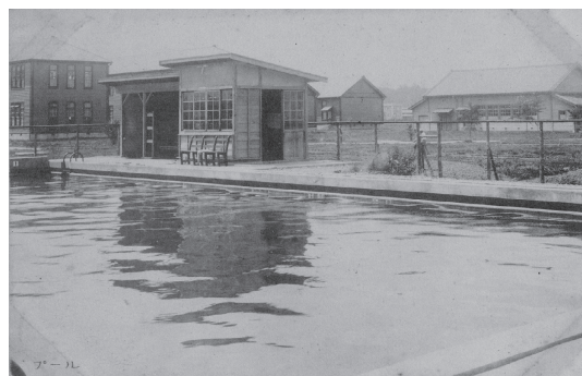
1931年（昭和6）頃 1930年に竣工した水泳部のプール。1937年に50センチメートル深くし、当時仙台市唯一の水泳公認プールとなった。
