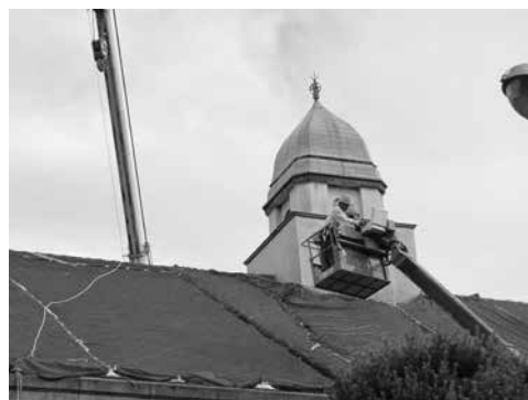
屋根へのブルーシートかけ
