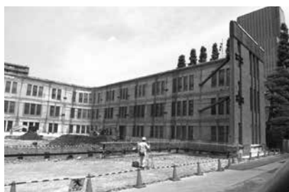
写真2：外壁保存工事（2011年）
